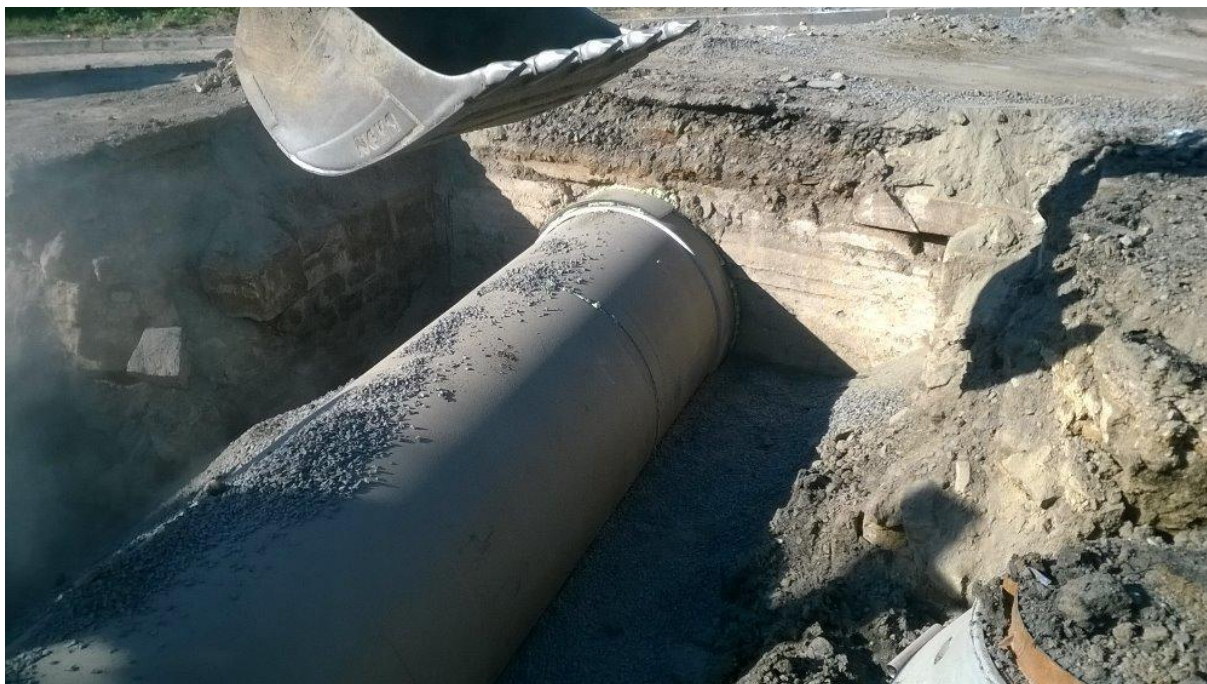
Obrázek 3. Budování kanalizace v obci.
