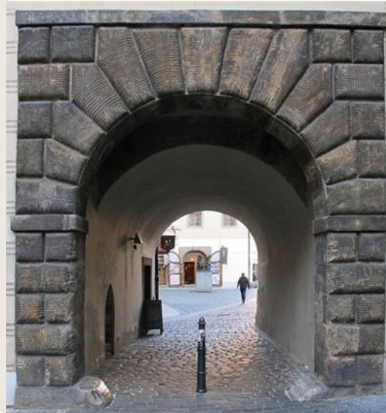
4 Praha, Staré Město, palác Granovských v Ungeltu, bosovaný portál vstupního rizalitu. Foto: Lenka Babická.
