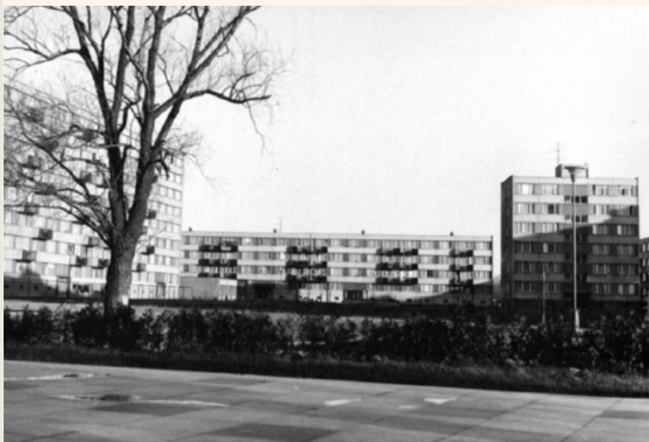
2 Pohled do vnitrobloku obytných panelových domů T06B, vlevo řadový osmipodlažní dům, uprostřed řadový čtyřpodlažní dům, vpravo bodový šestipodlažní dům, 1969. Foto: Státní okresní archiv Frýdek-Místek.
