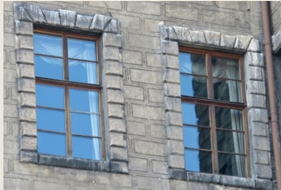
8 Nelahozeves, východní křídlo zámku, okenní otvory rámované bosovanými kvádry, 1553–1558. Foto: Lenka Babická.
