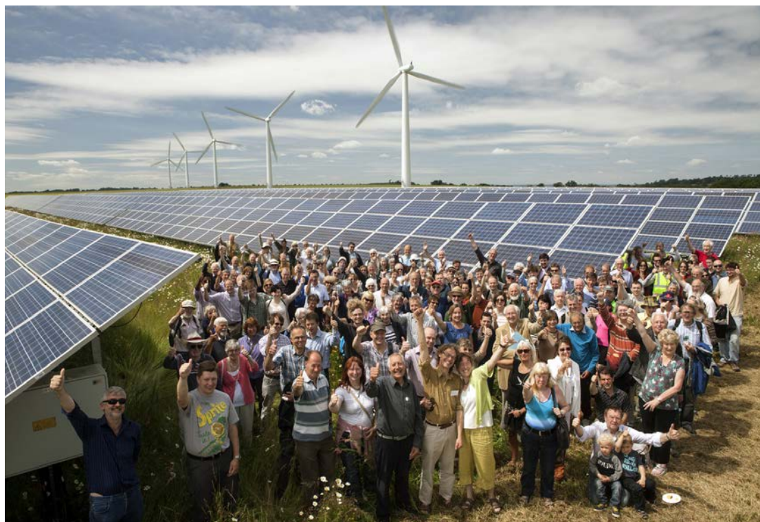
Největší komunitou vlastněná solární farma ve Velké Británii – Westmill Solar Coop blízko Oxfordu. Foto: www.brightonenergy.org.uk
