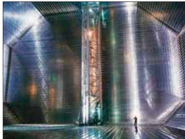
Obr. 11: Membránový tank s čerpacím stožárem 77
