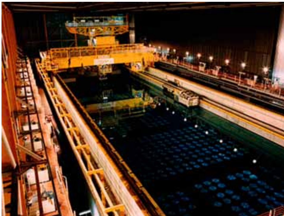
Obr. 48: Chladicí nádrž pro použité palivo v recyklačním závodě Sellafield, Velká Británie 503
