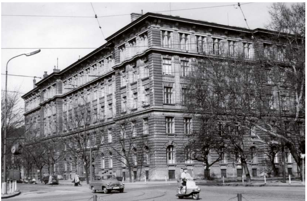
— Významné budovy v dějinách MU. Vlevo nahoře Kounicův palác, tradiční sídlo Rektorátu MU, foto z počátku 20. století. Vpravo nahoře Zeměbranecká kasárna, po roce 1919 první sídlo Lékařské fakulty MU, foto z počátku 20. století. Dole snímky budov Německé techniky, vlevo budova z roku 1860 na Komenského náměstí, vpravo stavba z roku 1910 v Joštově ulici. Po zrušení Německé techniky v roce 1945 obě budovy užívala MU. V areálu na Komenského náměstí sídlila až do roku 2010 lékařská fakulta. Budova v Joštově ulici je nyní sídlem Fakulty sociálních studií MU.
