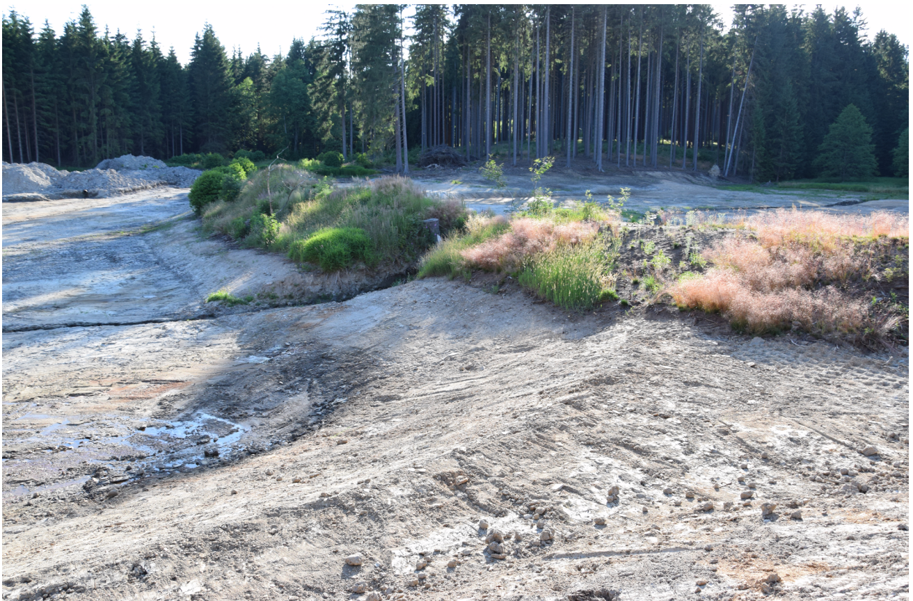
Obr. 50: Výstavba MVN RN Malovaný mostek na k.ú. Jestřebí u Brtnice (okr. Jihlava) v průběhu roku 2019. Neoddrněná část představuje staré těleso hráze, které je v současné době zatopeno, vzadu v levé části v lese se nachází ZSV Střenčí, ke které dosahuje část výstavby MVN.
