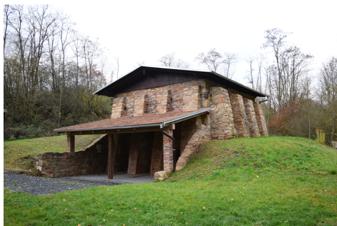
Obr. 25 (dole): Rekonstruovaný objekt bývalé cihelny (k.ú. Zbýšov u Brna, okr. Brno-venkov).
