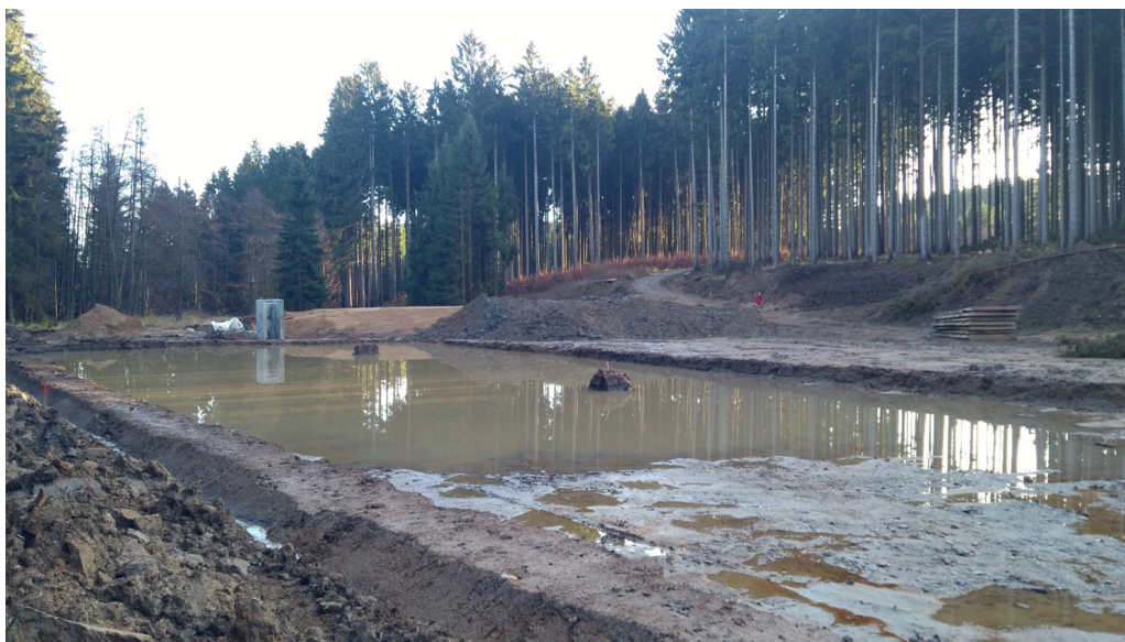
Obr. 6: Zaniklá rybniční hráze na Kněžickém potoce, která je znovu použita po domluvě a změně projektu se stavebníkem Lesy ČR do nové hráze retenční nádrže (retenční nádrž Telč Horní, k.ú. Jestřebí u Brtnice).
