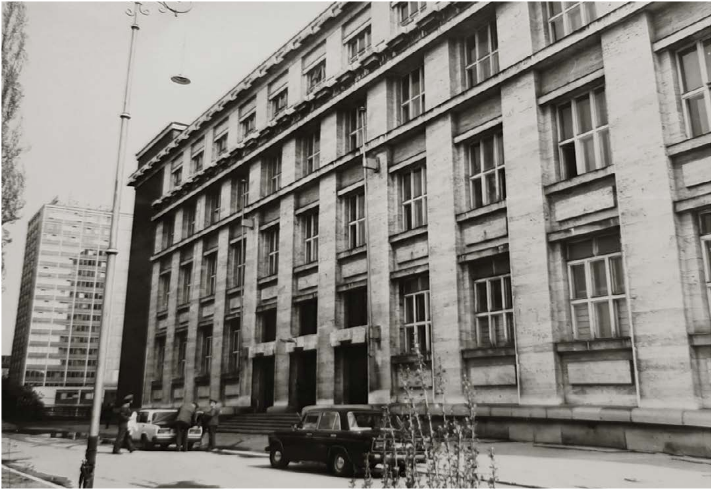
28 | Budova fakulty na přelomu sedmdesátých a osmdesátých let
