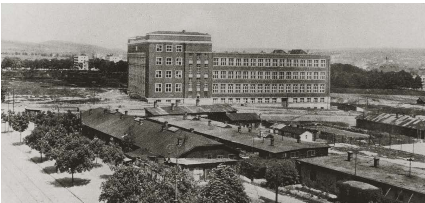
16 | Budova fakulty bezprostředně po jejím dokončení v první polovině třicátých let
