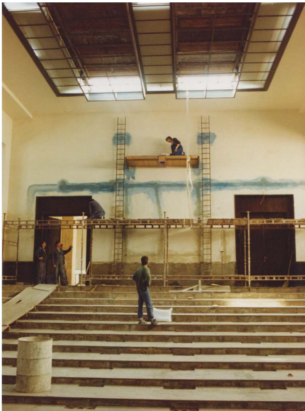
56 | Auditorium maximum – rekonstrukční práce (květen 1994)
