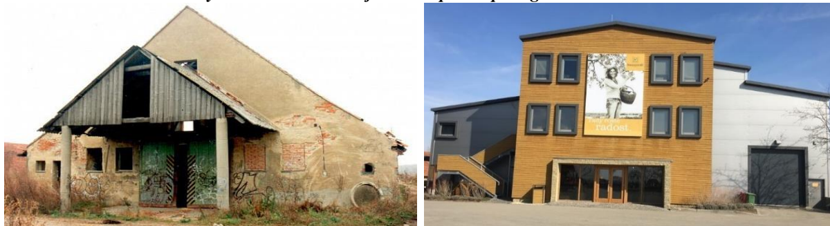
Obr. 3 Pohled na budovu bývalého kravína v Čejkovicích před a po regeneraci
