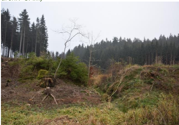
Obr. 16: Pohled na hráze s parcelním číslem 845 po odlesnění s viditelným proražením hráze v místě původní propusti a uloženým zatrubněním v její východní části zasypané hutněnou zeminou z profilů proraženého tělesa hráze (foto archiv ÚAM).
