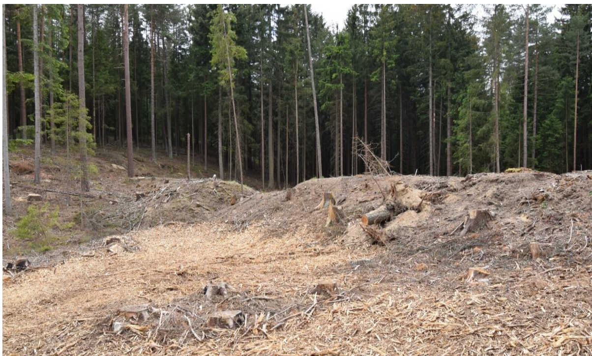
Obr. 10: Hráz zaniklé nádrže, která byla predikována pomocí modelu. Při ověření v terénu bylo zjištěno, že na hrázi došlo k těžbě kůrovcem zasaženého lesa, naštěstí však nedošlo k poškození hráze samotné, autor RokLAB (VVS Panská Lhota).
