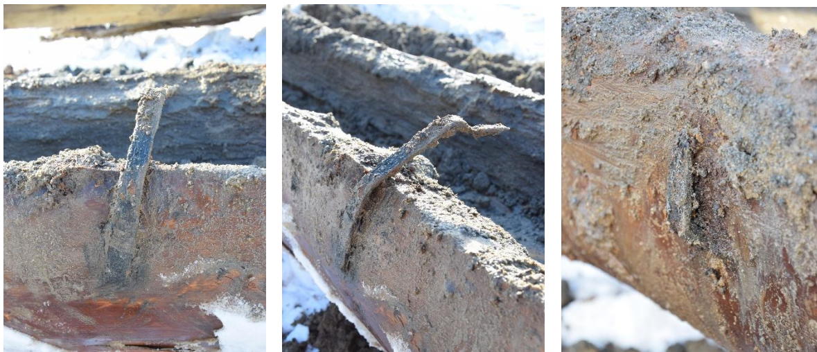
Obr. 25: Spojovací dvouramenná skoba (kramle) na dřevěné rouře výpusti spojující dolní koryto s horním, foto archiv ÚAM FF MU.
