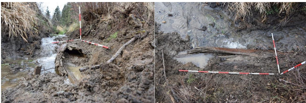
Obr. 21: Dřevěné zatrubnění: výpust' rybníka v proražené hrázi parcelní č. 845, k.ú. Jestřebí u Brtnice; archiv ÚAM FF MU.
