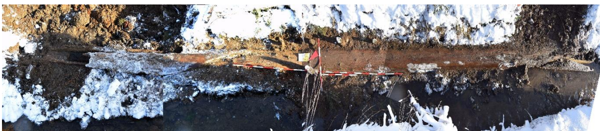
Obr. 22: Pohled na dřevěné výpustní zařízení rybníka Zweitämmige, archiv ÚAM FF MU.
