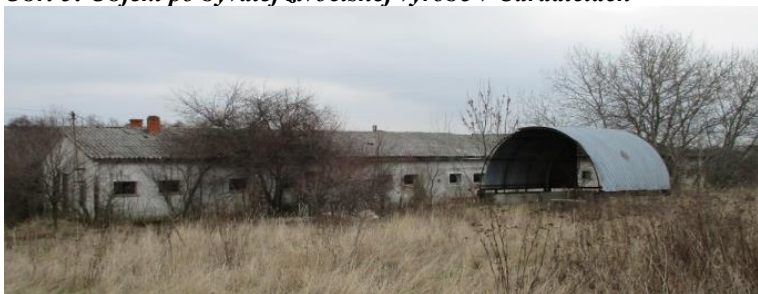
Obr. 5: Objekt po bývalej živočíšnej výrobe v Čaradiciach
