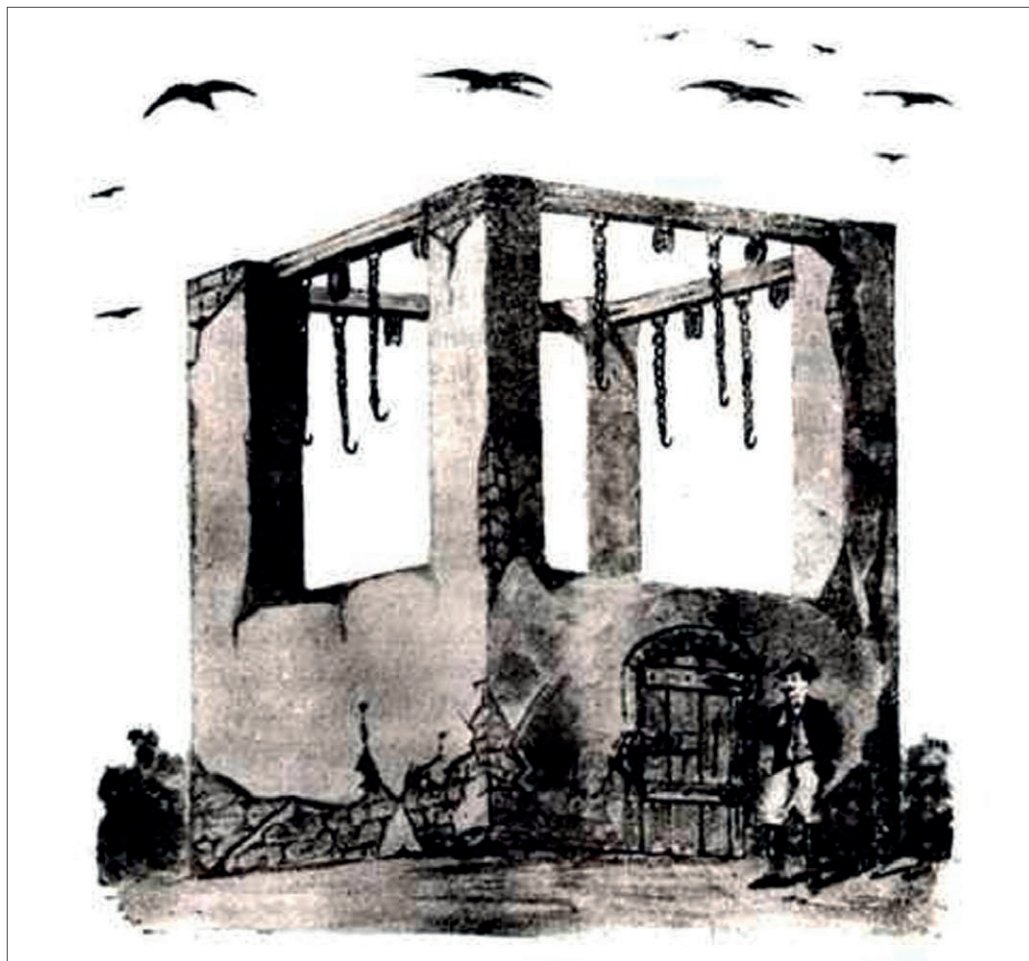
Obr. 2. Rekonstrukce typické šibenice na čtvercovém půdorysu s vchodem do interiéru. Na trámech jsou řetězy. Archiv autora
