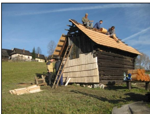
Obr. č. 18: Vlkolínsky senník po obkopení, výmene spodných brvien a s novou šindľovou strechou (vpravo) a obnovený senník pri parkovisku (vľavo)
