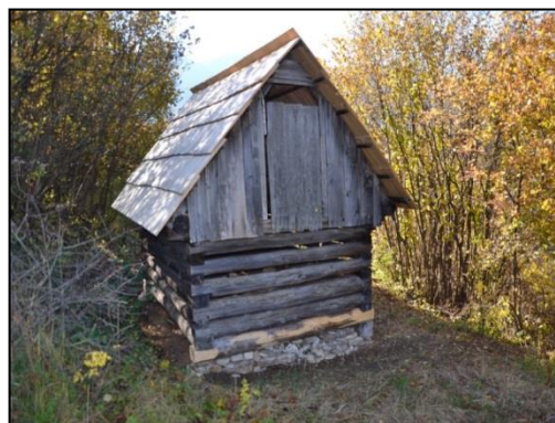
Obr. č. 18: Vlkolínsky senník po obkopení, výmene spodných brvien a s novou šindľovou strechou (vpravo) a obnovený senník pri parkovisku (vľavo)
